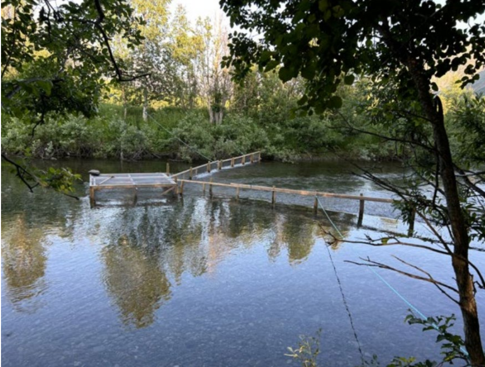
Figur 3.3. Ferdig montert nettingfelle og ledegjerde i Røyeelva. Foto: Reisa Elvelag.
