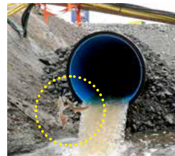
To gytefisk av sjøørret forsøker å passere opp til gyteområdene i Ratbekken høsten 2017, men må gi tapt for summen av høydesprang, vannhastighet og lengde på rørlagt strekning i forbindelse med anlegging av ny E6.
