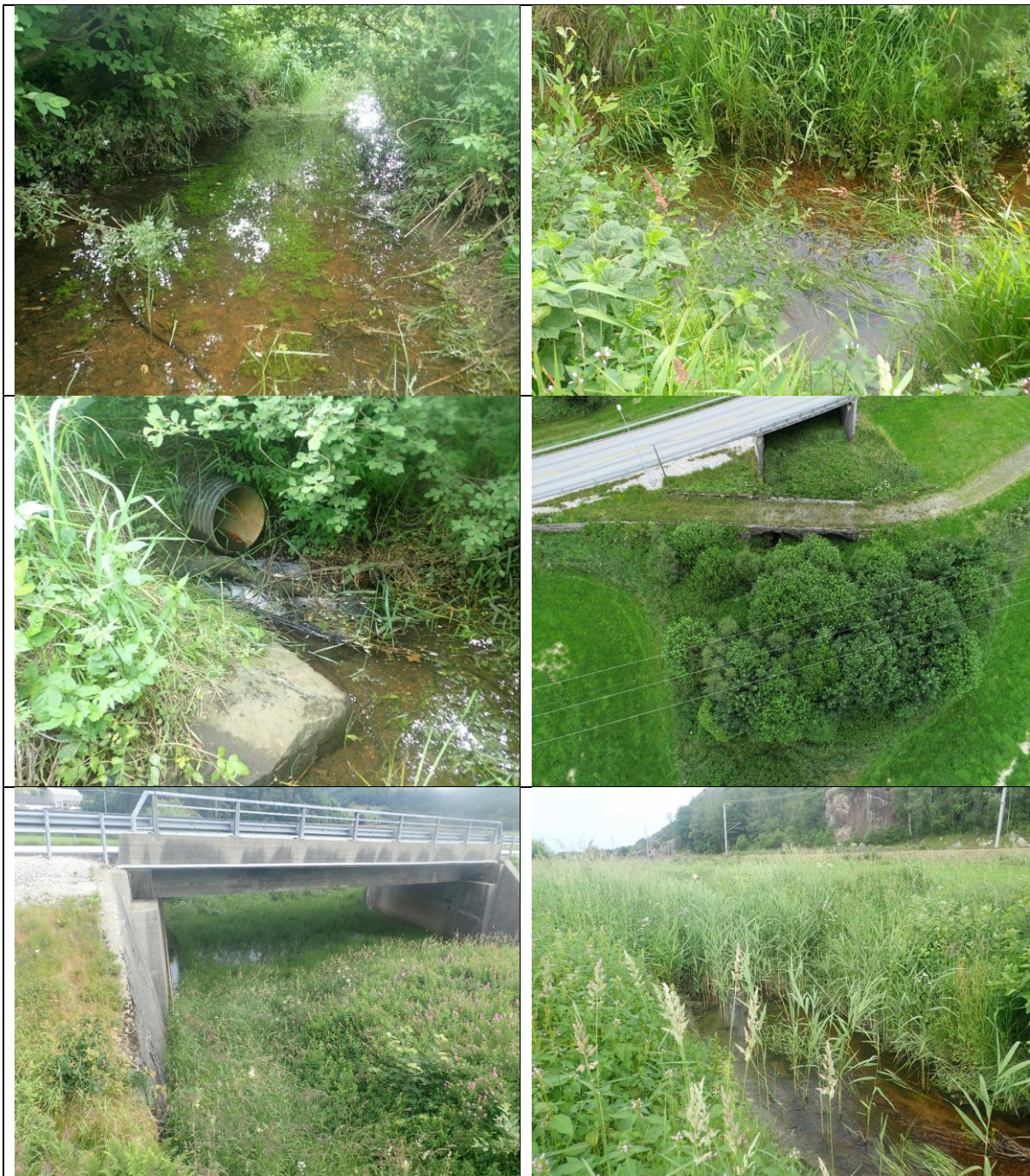
Figur 25. Bilder fra de øvre 450 meterne av Litlåna hvor det må grøftes en god del. Øvre rad viser bilder av de aller øverste delene av bekken hvor det i hovedsak må fjernes mudder/finsedimenter. Vollen oppstrøms Krossmovegen kan sees på bildene i midtre rad. Tilgrodde strekninger ved- og nedstrøms Krossmovegen kan sees nederst.
