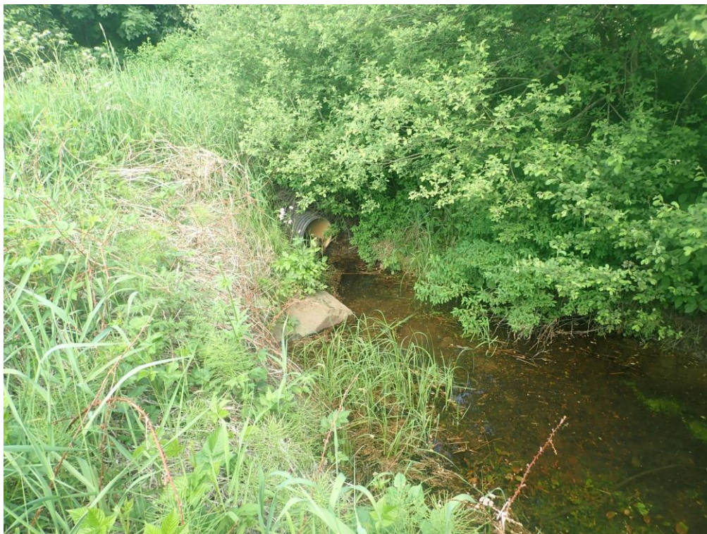
Figur 17. Vanninntaket fra Hellelandselva til Litlåna. Merk at ved lav vannføring går det ikke vann inn i røret.
