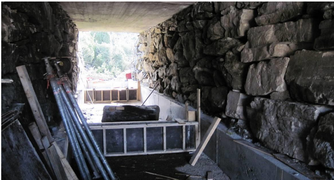
Figur 6. Bildet fra bygging av ny veikulvert ved en bekk i Sotra, Hordaland våren 2010. Her støpes det tverrvegger for å lette oppvandringen for fisk.
